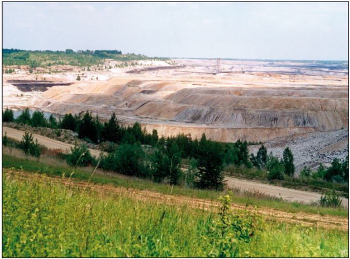
Bild 10: Abraum-Innenkippe (Baufeld-Süd) im Tagebau Profen. 2004.
