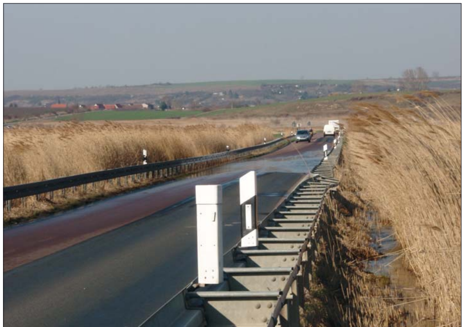
Abb. 4: Der Verlauf der L 179 von Aseleben nach Röblingen am See durchschneidet die Röhrichtflächen der „Teufe“ und stellt für die Avifauna des Schutzgebietes einen der wesentlichen Störfaktoren dar. Foto: R. Zschäpe.
